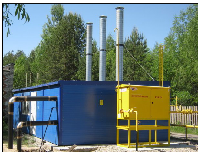
Рисунок 1.2.9. БМК №15 ул. Дзержинского,2
